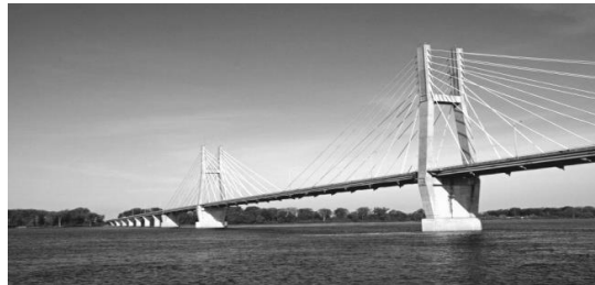
Şekil 3. Quincy Bayview Köprüsü
