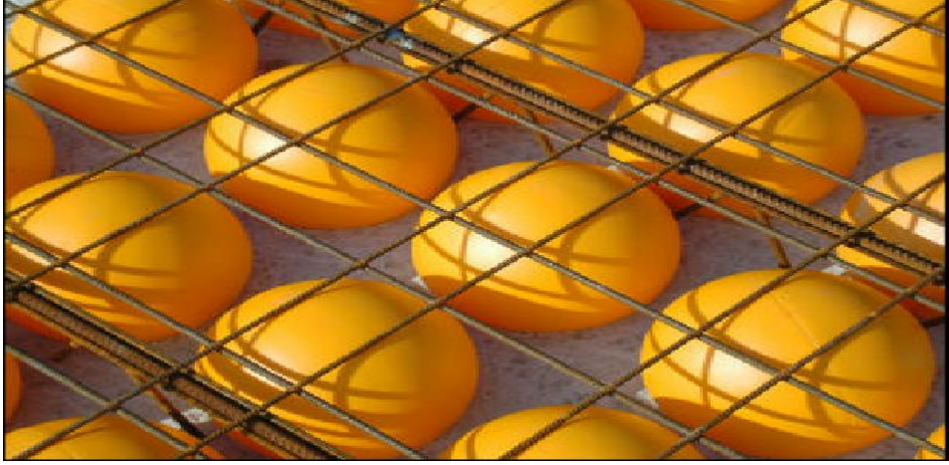
Şekil 6. BubbleDeck firmasının yeni nesil döşeme sistemi [14].
